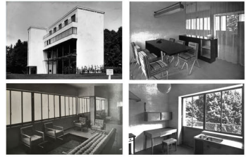
Dall'alto: La "casa a struttura in acciaio" di Albini, Camus, Mazzoleni, Minoletti, Palanti. L'esterno e gli interni. Milano, 1933.
