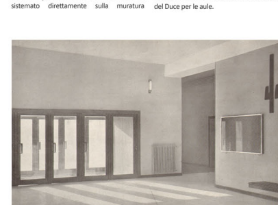
Ingresso principale visto dall'atrio.
