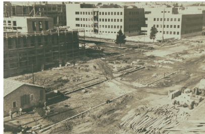
L'edificio in corso di costruzione, 1934; Archivio Storico Sapienza, Fondo CERLUR.
